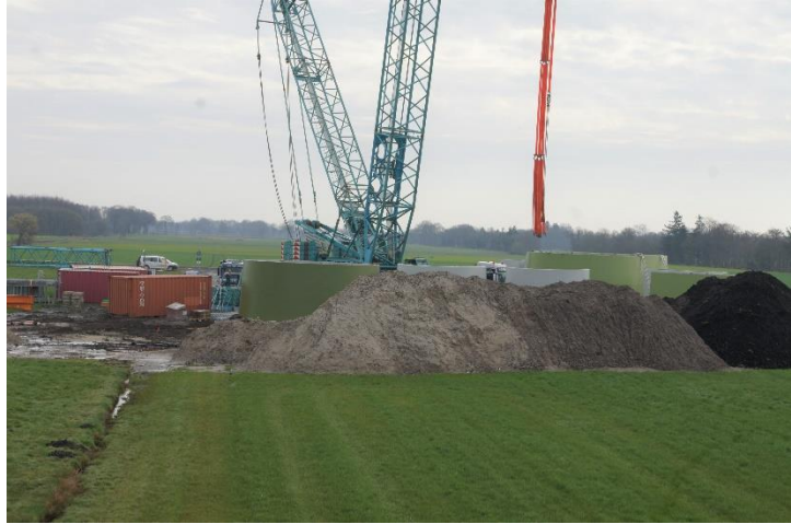
Wiederaufbau WEA E82 (Enercon)
